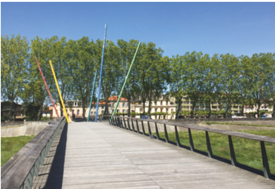
La passerelle piétonne Dax
