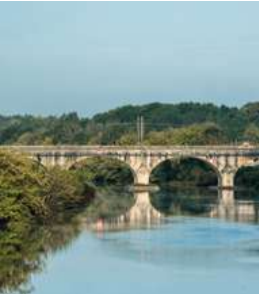
La passerelle piétonne dax
