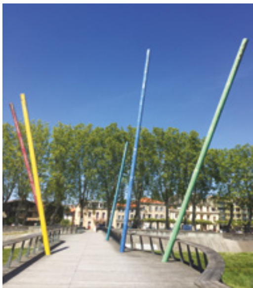
La passerelle piétonne dax
